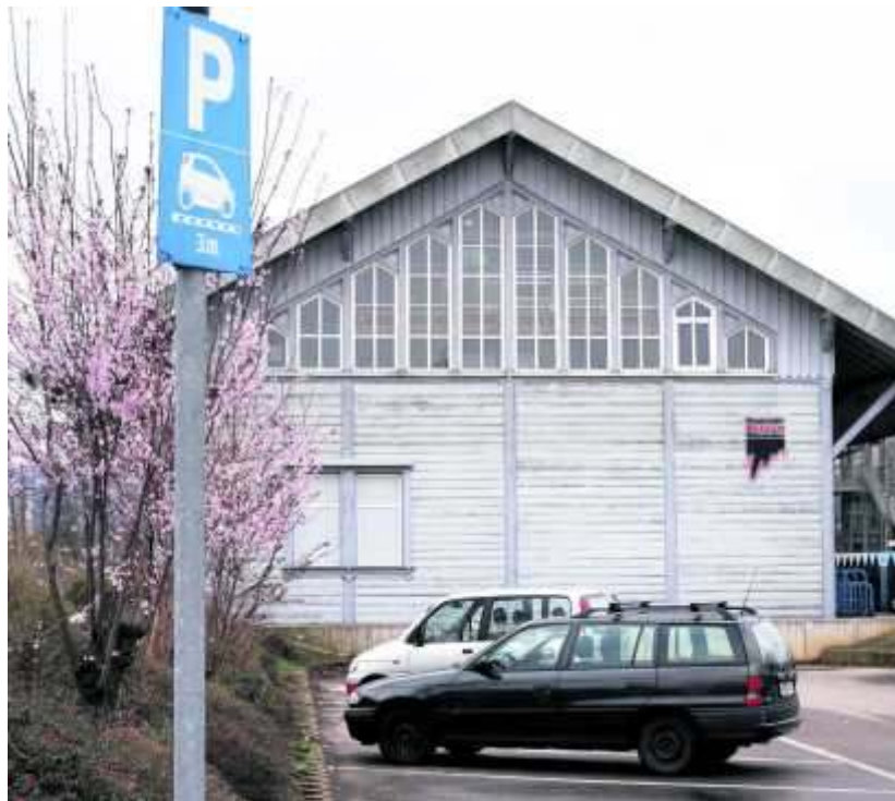
Rückseite des Feuerwehrmuseums: Hier könnte angebaut werden. Bild: Steinemann
